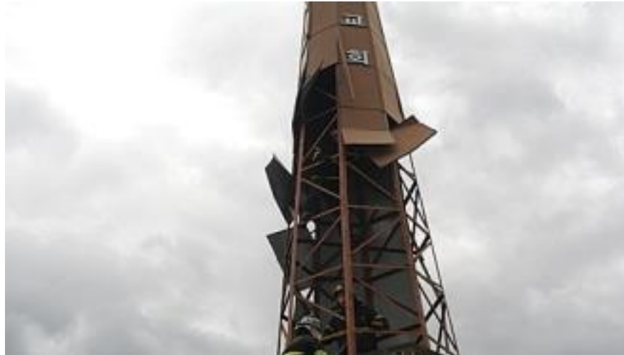
그림 3.4 강풍에 의한 종각형 장식탑의 판 부재 파괴
