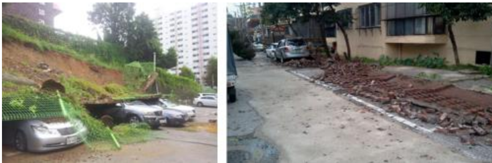
그림 1.11. 태풍에 의한 태양광 발전시설, 담장 및 옹벽 피해 사례(2012년)
