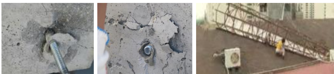
그림 3.3 지지부의 부식 방지 및 균열확인의 중요성
